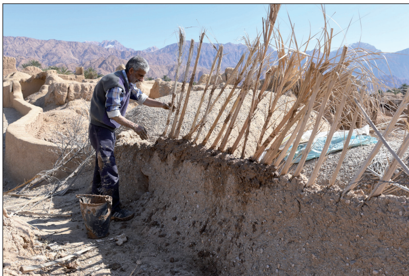
Obr. 1 Esfahak – oprava hliněného zdiva vyztuženého palmovými listy. Foto M. Novotný, 2019.
