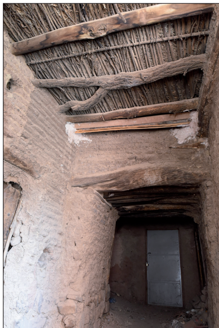
Obr. 2 Abyaneh – subtilní konstrukce stropu. Foto M. Novotný, 2019.
