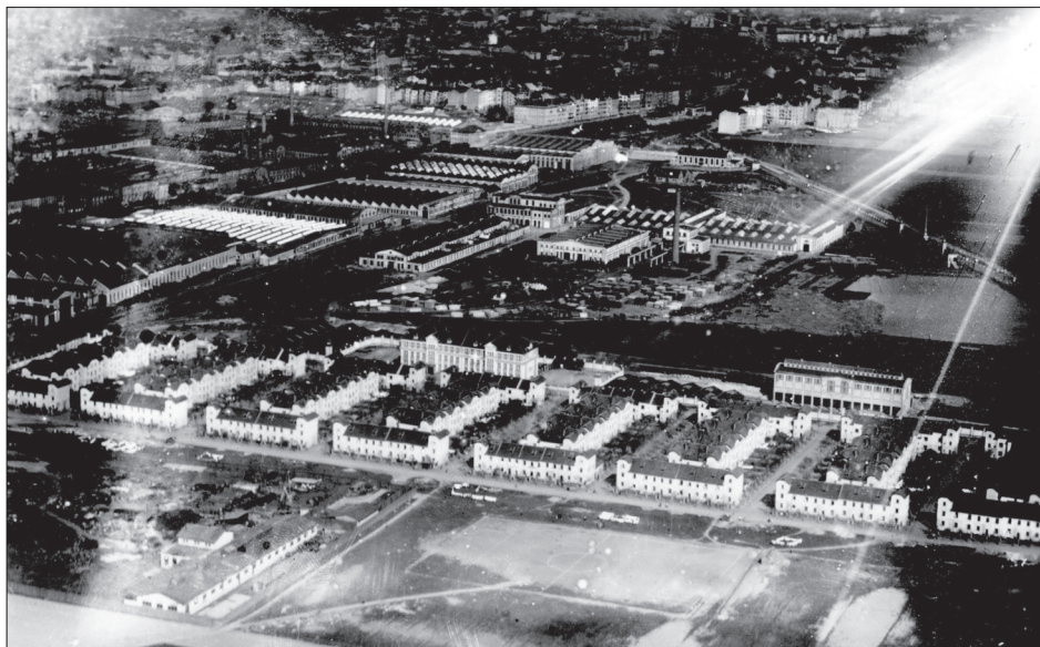
Obr. 2: Letecká fotografie Karlova z období krátce po výstavbě (přesná datace neznámá), na které je vidět fotbalové hřiště, budova školy, lázně a v pozadí Škodovka. Foto: Archiv SOA Plzeň.
