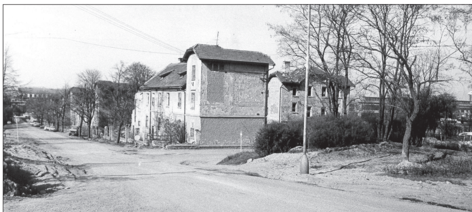
Obr. 4: Ulice Na Pomezí v 80. letech 20. století, krátce před demolicí Karlova. Foto: Osobní archiv informátorů.
